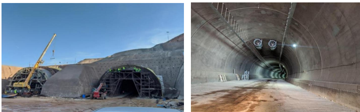
Figure IX.2 - Portail d'entrée ainsi que l'intérieur du tunnel
