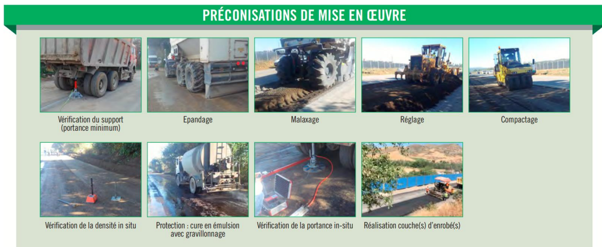
Figure I.3 – Préconisations de mise en œuvre de la méthode de recyclage des chaussées
