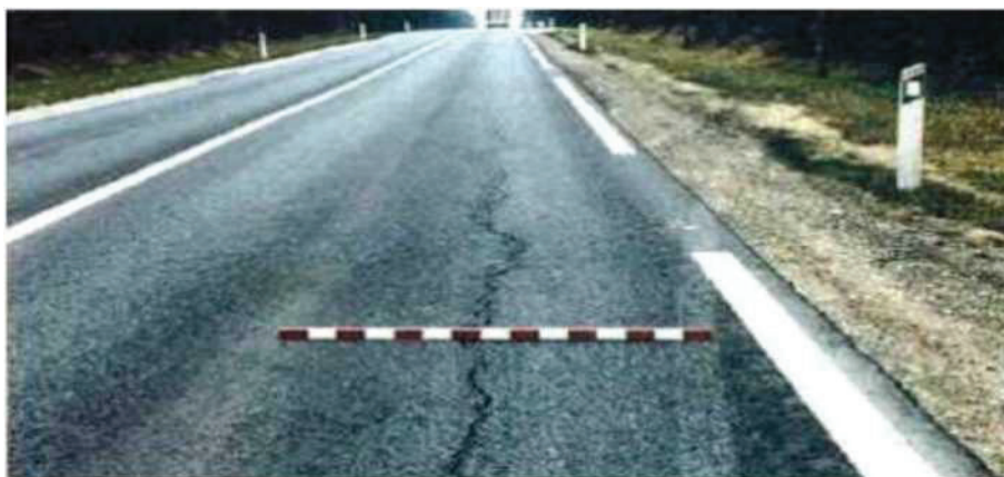
fig.II.5 : Fissuration longitudinale
