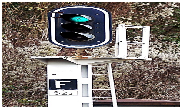
Figure XIII:1 Implantation des signaux à gauche sur mat
