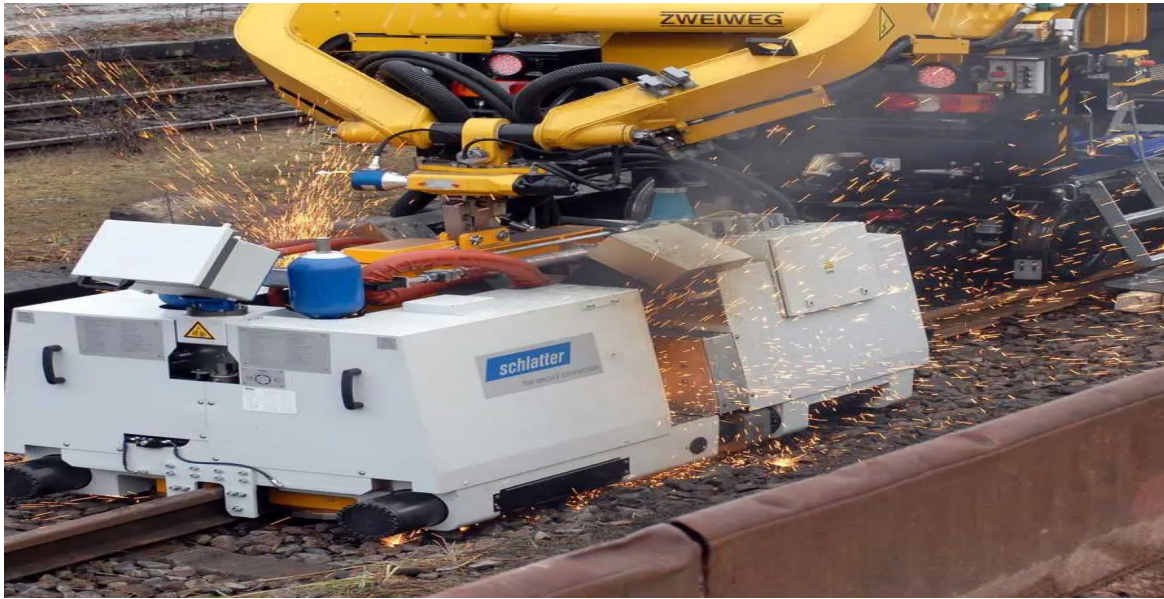
Figure III:6 La machine mobile de soudage électrique
