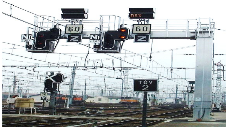
Figure XIII:2 Implantation des signaux sur potence
