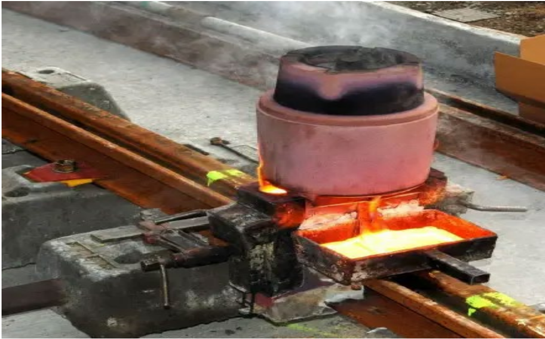
Figure III:7 Soudage aluminothermique
