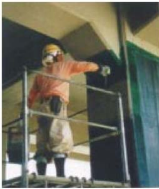
(a) Pile de viaduc
