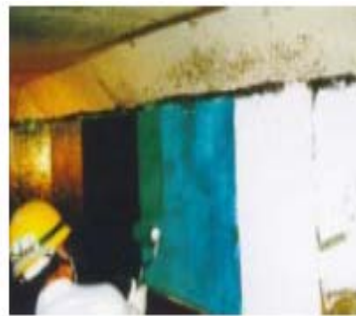
Figure 1-17(a,b) : L'utilisation du carbone pour la réparation d'un quai à Tokyo.
