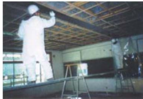
(e) Réparation des dalles.
