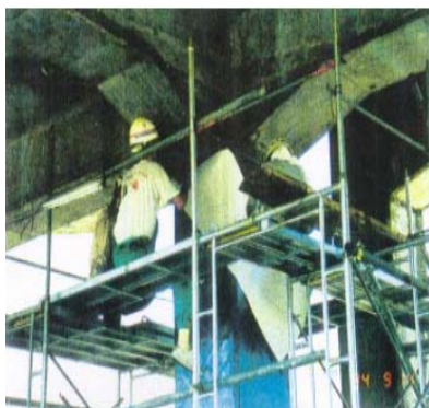
Figure 1-14(a,b) : L'application de carbone pour le renforcement des piles du viaduc Tsushima.
