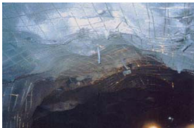
Figure 1-11 : L'application des composites pour les surfaces irrégulières des tunnels.
