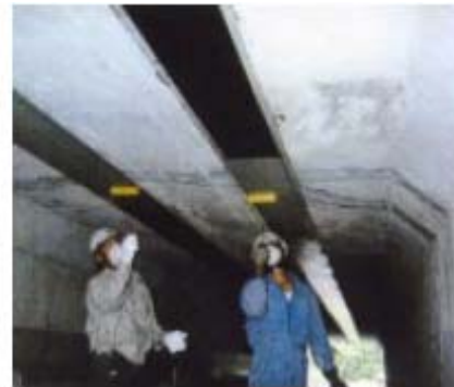
Figure 1-16 : Réparation interne d'un dalot.
