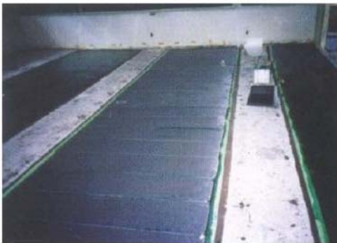
(d) Réparation d'un étage fissuré.
