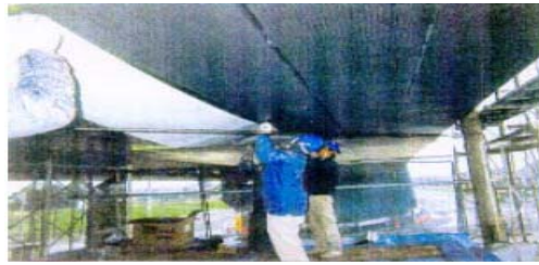
Figure 1-15 : Réparation des fissures du tablier de viaduc Koyahara. (Collage longitudinal et aligné des tissus)
