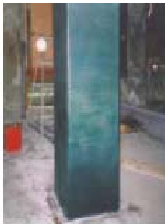
(b) après la réparation.
