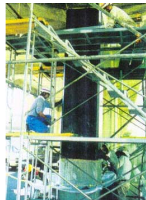
Figure 1-14(a,b) : L'application de carbone pour le renforcement des piles du viaduc Tsushima.
