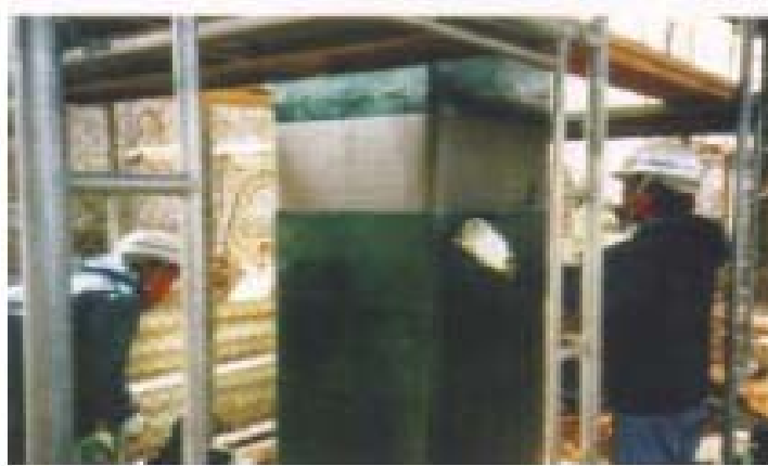
Figure 1-12: Réparation des fissures de la pile au moyen du carbone (pont de Shinkansen).
