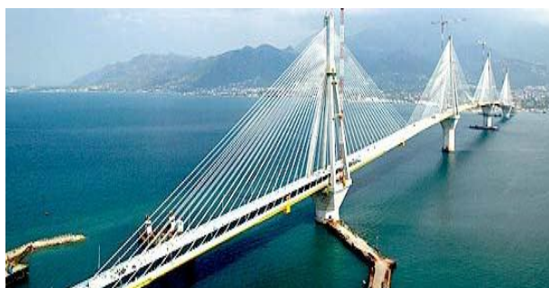
Fig I.1 : Pont à haubans [87]
