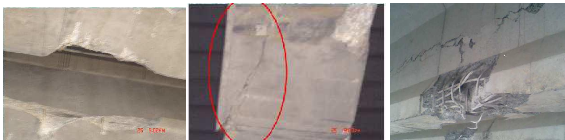
Fig. I.16 : Les différentes dégradations causées par le choc [53]
