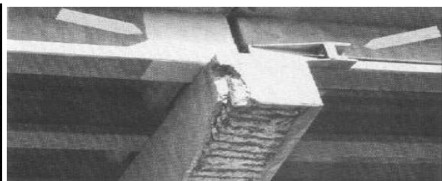
Fig I.28 : Délamination à la base d'une poutre [90] Fig I.29 : Délamination dues à la corrosion dans un caisson en béton armé. [90]
