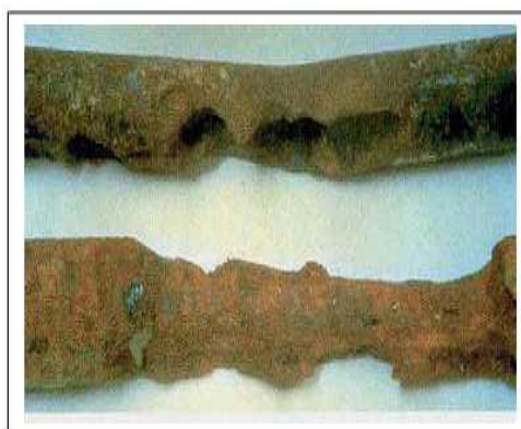
Fig. I.10 : Piqure profonde causée par une attaque de chlorure [54]
