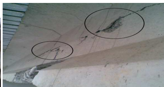
Fig I.25 : Epaufrure cause par le choc [53]
