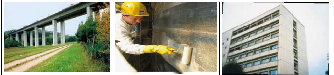
Fig. IV.4 : Renforcement d'un ouvrage d'art [76]
