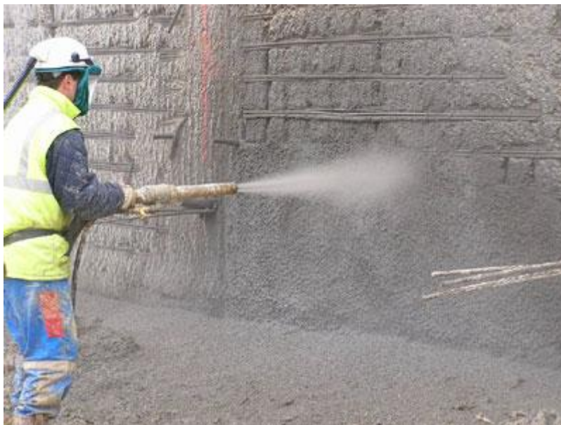
Fig. 2.3. Projection du béton sur un mur en maçonnerie
