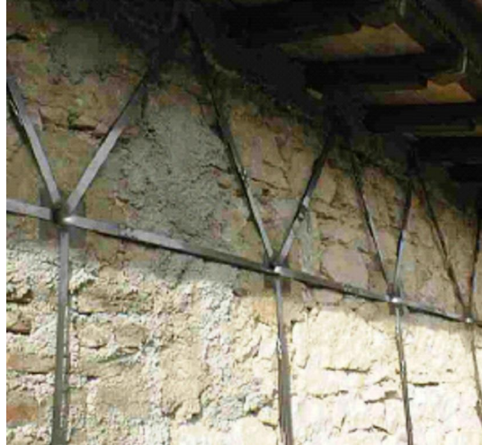
Fig. 2.21 Différents sens du renforcement par les rubans
