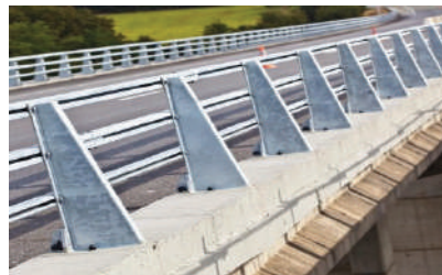
Figure IX.4. Garde-Corps en métal BN4
