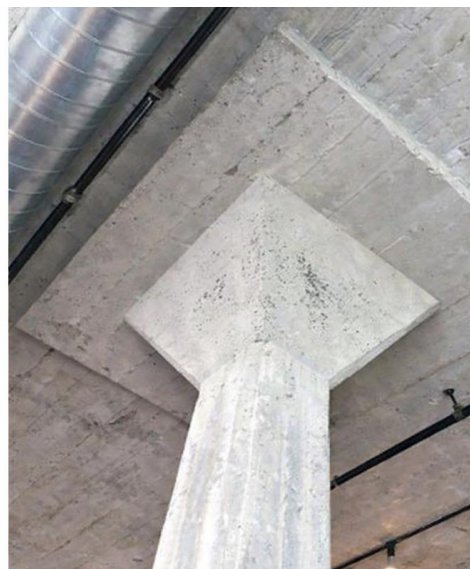
Figure I.8 : Dalle plate avec tête et avec retombée de panneau [13]
