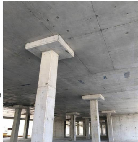
Figure I.7 : Dalle pleine sans tête et avec retombée de panneau [13]
