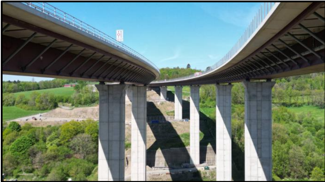
Figure II-1 : Pont à poutres précontraintes par post tension.
