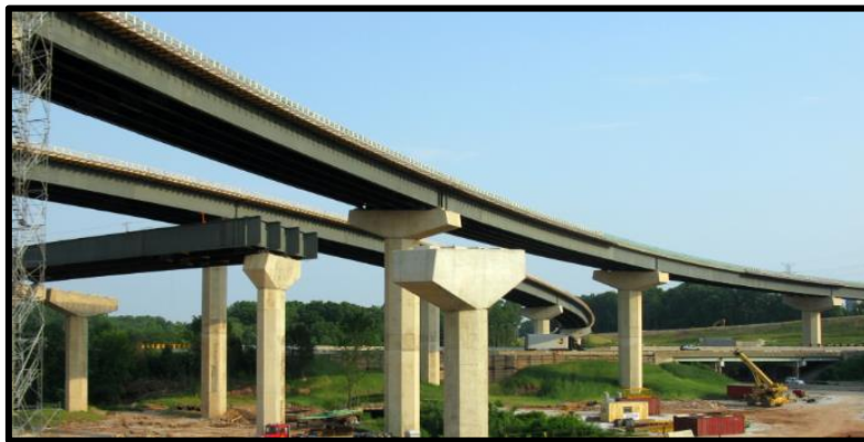
Figure II-3: Pont mixte bi-poutre
