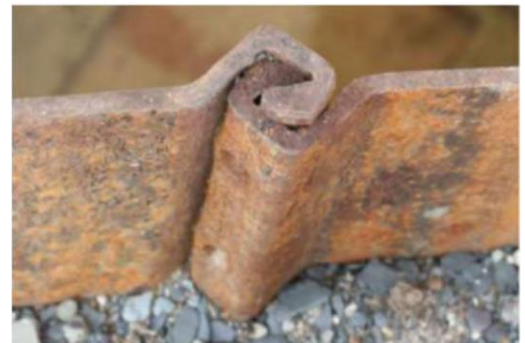
Figure I. 3 : Rideau de soutènement réalisé en palplanches métalliques cas d'une fouille
