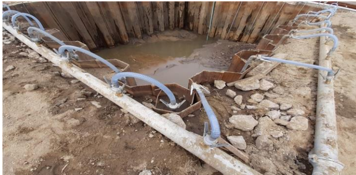
Figure I. 3 : Rideau de soutènement réalisé en palplanches métalliques cas d'une fouille
