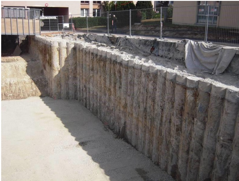
Figure I. 9 : Parois en pieux jointifs
