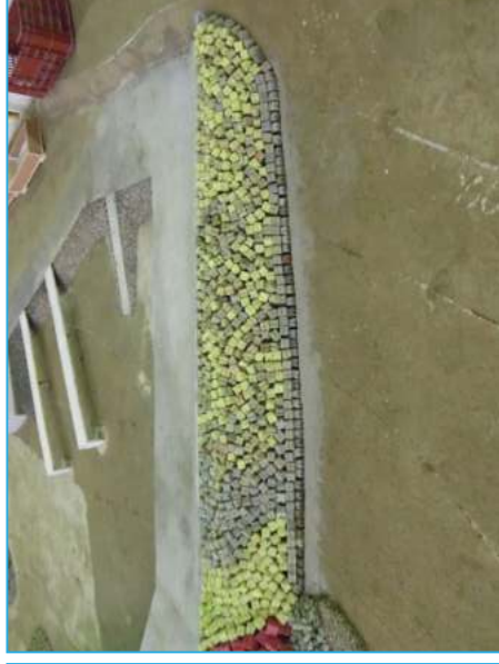
Figure D. 53 : Vue de la variante 2.3 avant essai. -Remplacement des enrochements du profil enraccinement de la jetée principale par des BCR de 10 t
