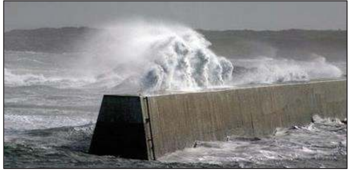
Figure M. 4 : Vue des franchissements et de l'effet de choc de la houle sue le couronnement de la jetée.
