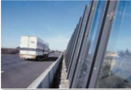
Mur de protection
