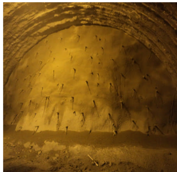
-Front de taille avec fibre de verre-
