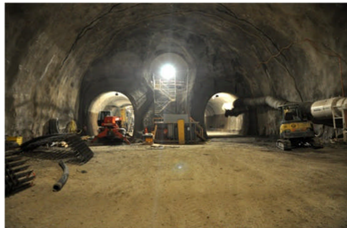
-Creusement en section divisée-
