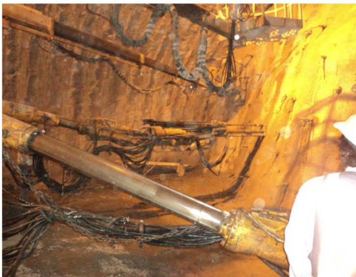
-La mise en place des fibres-
