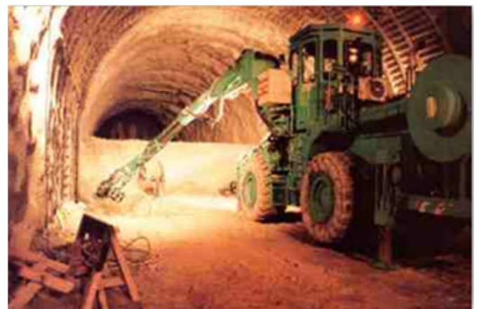
-Creusement en demi-section-
