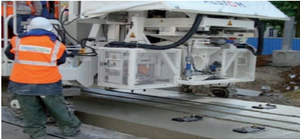
Figure I. 9 voie à attaches directes
