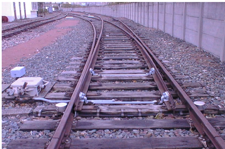
Figure IX. 3 Commande électrique d'un aiguillage
