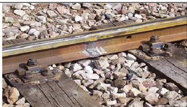
Assemblage par soudage
