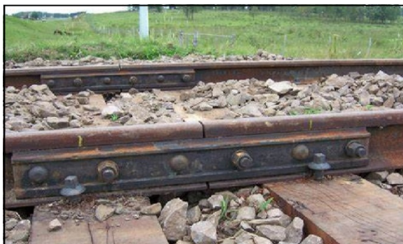
Assemblage par éclisses
