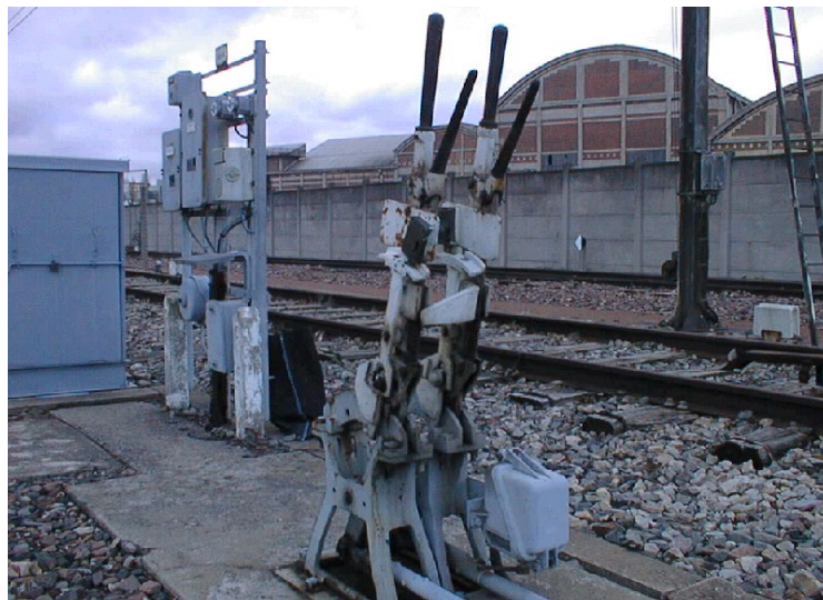
Figure IX. 2 Commande à pied d'œuvre des aiguillages
