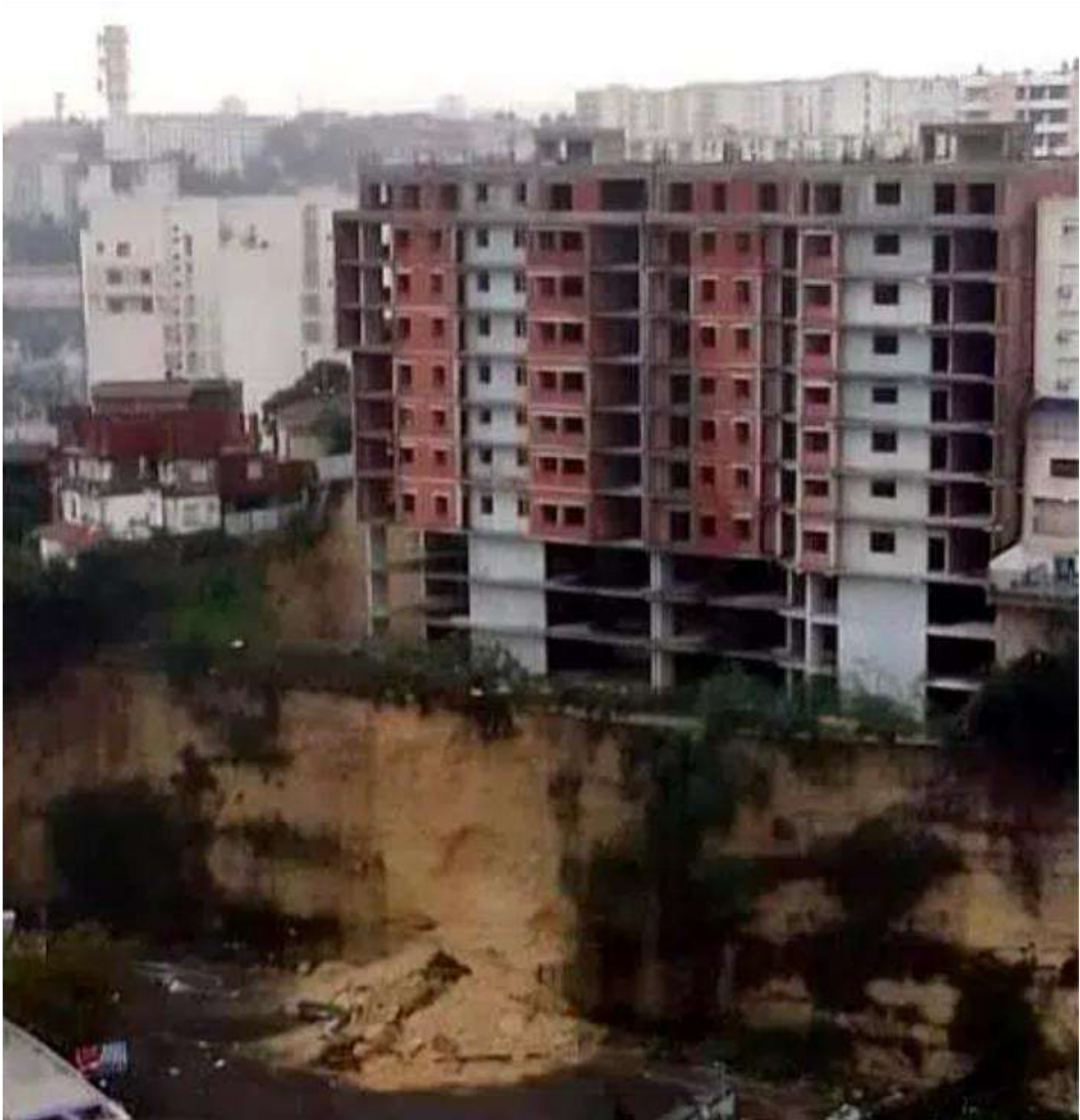
Figure 4: Glissement de terrain au niveau de la station de transport à Bir Mourad Rais, Alger 2021, source : Algérie-focus.com.
