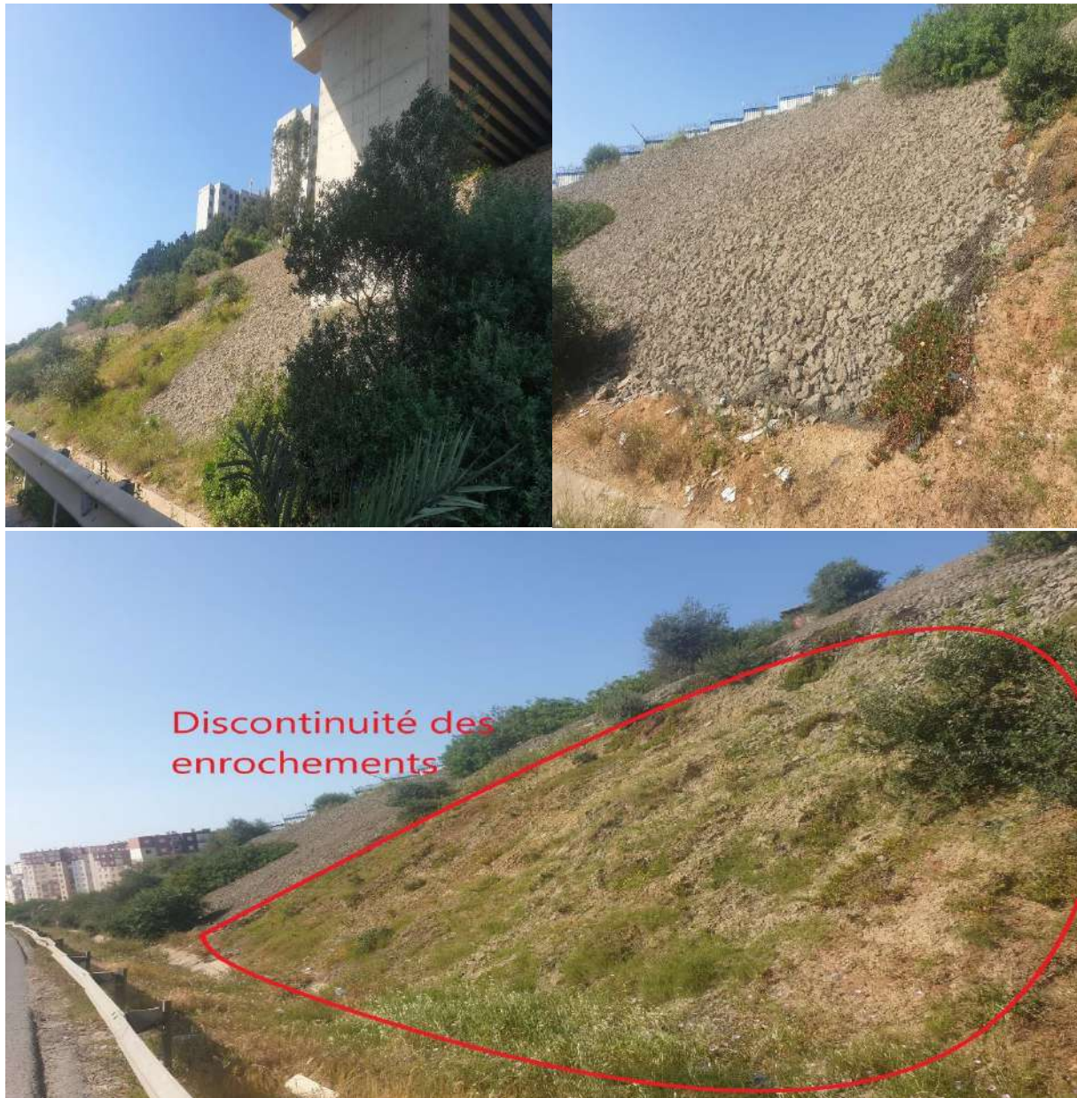
Figure VII-10: Etat du talus en place, mai 2022.
