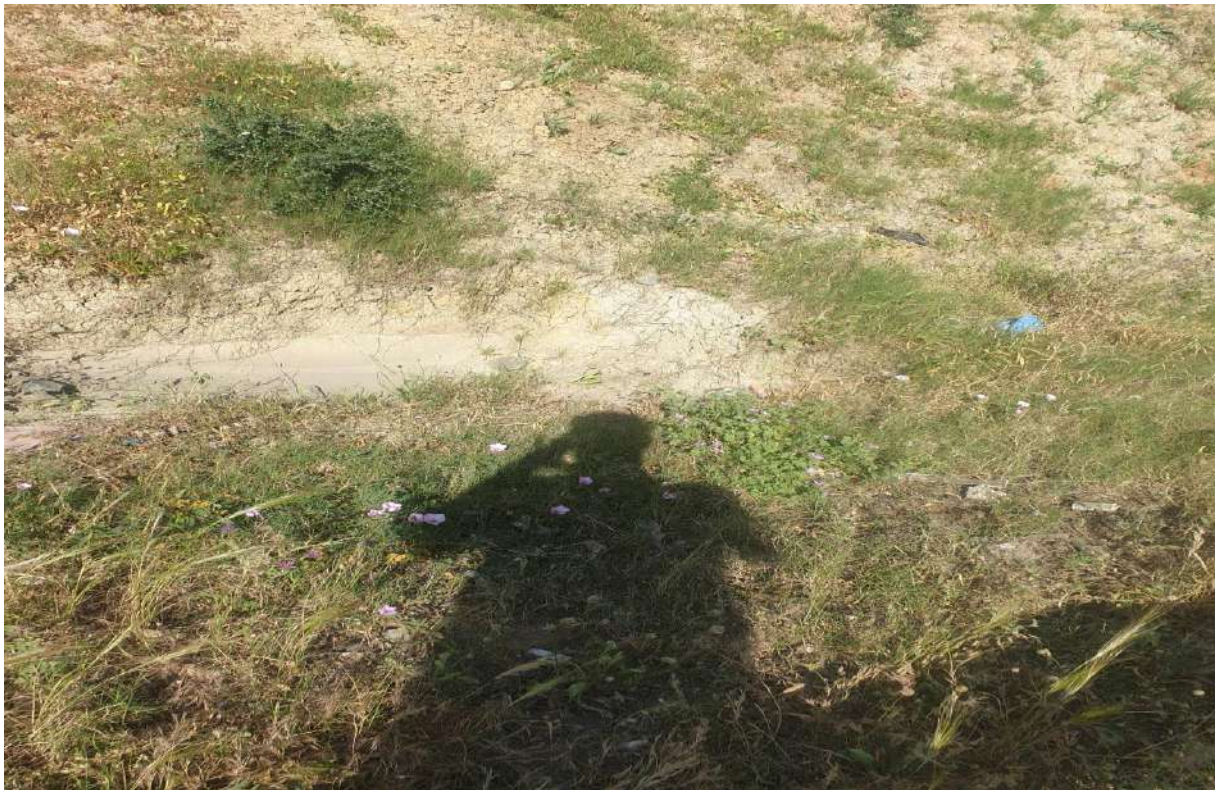
Figure VII-11: Fossé complètement bloqué par les dépôts de solide.
