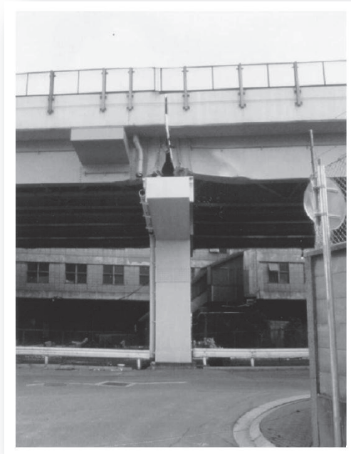
Figure 1.8 : Connections et joints de dilatation. a) Northridge ; 1994, b) Hyogo-Ken Nanbu (Japon, 1995)
