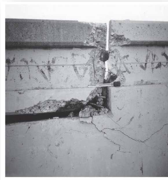
Figure 1.8 : Connections et joints de dilatation. a) Northridge ; 1994, b) Hyogo-Ken Nanbu (Japon, 1995)
