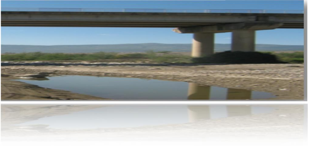
Figure 1.4-Affouillement des piles.
