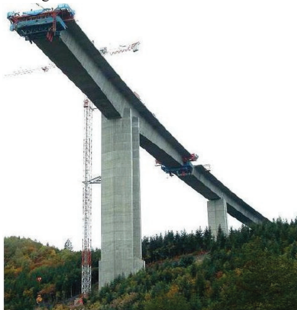
Figure I.3 Voussoir coulé sur place
