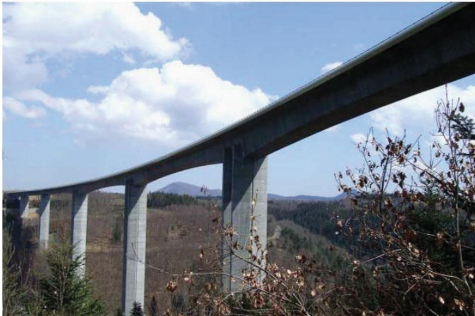
Figure I.1 Pont construit en encorbellement successif
