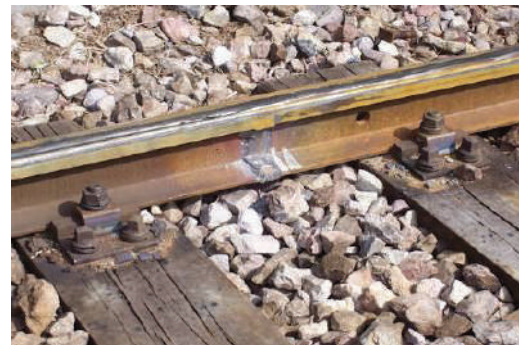
Figure IV. 5 Assemblage par soudure
