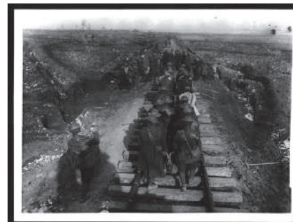
Figure I. 9 pose des traverse par des soldats
