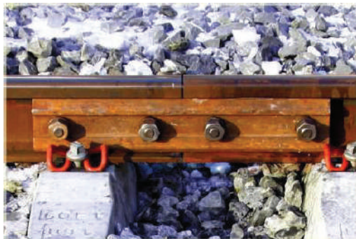
Figure IV. 6 Assemblage par éclissage
