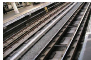
Figure I. 14 Traverse en échelle
