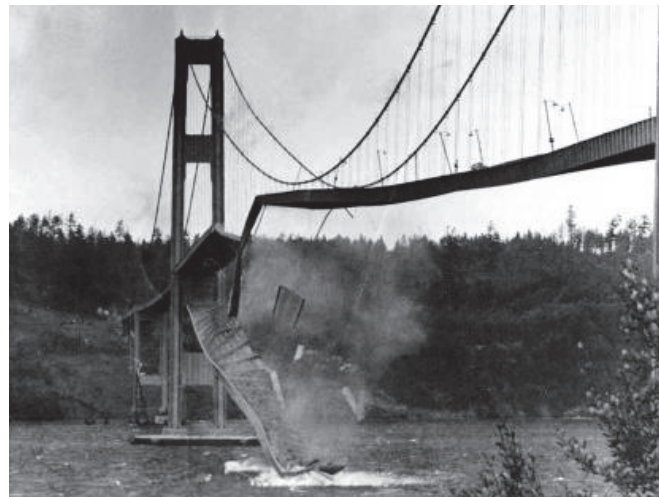
Figure I.4. La chute du pont de Tacoma.
