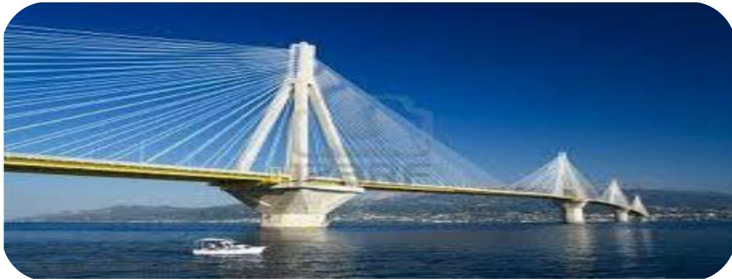
Fig. I-3 : Pont à haubans.
