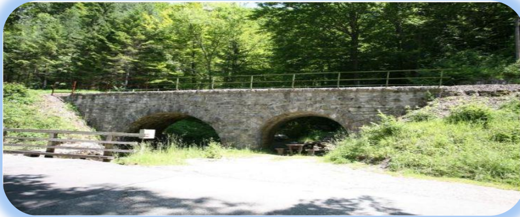
Fig. I-1 : Ponts en maçonneries.
