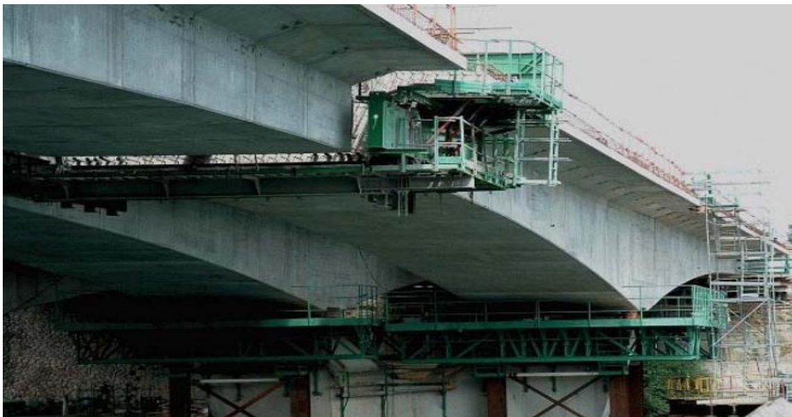
Fig. III-2. voussoirs culée en place.
