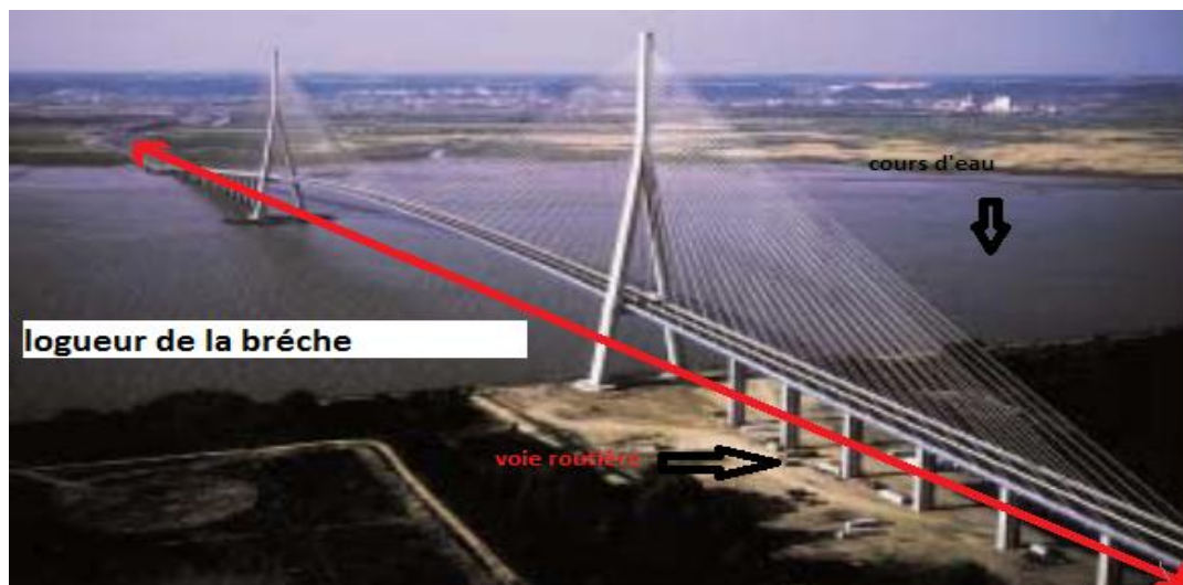
Fig. I-4 : longueur de la brèche.
