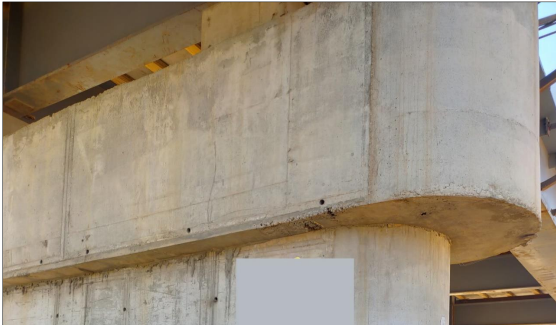
Figure IX.1 : Chevêtre sur une pile voile.
