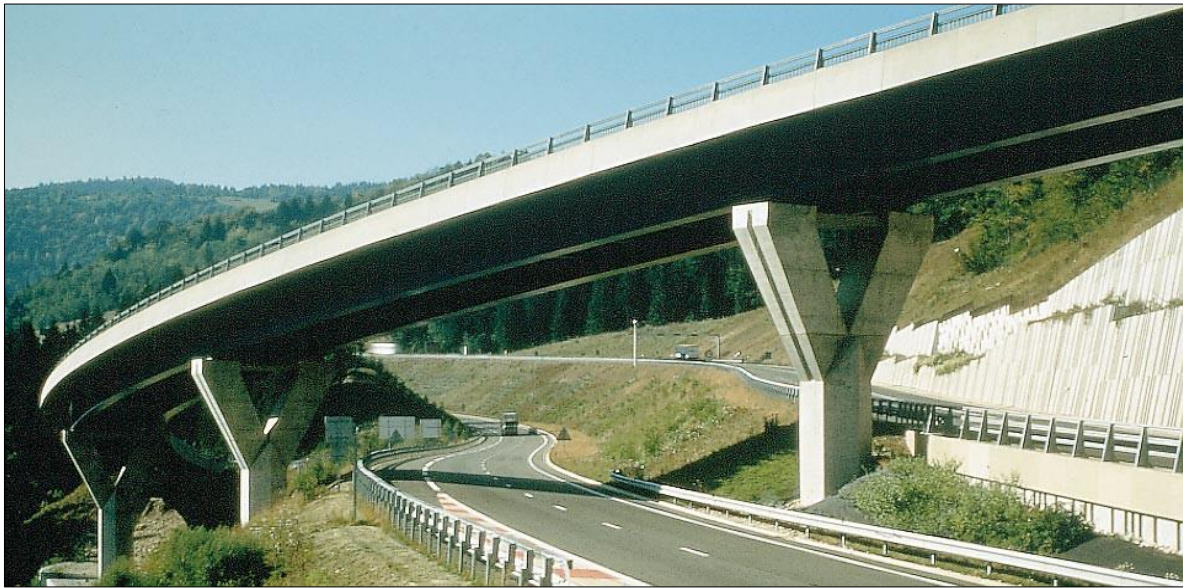
Figure I.2 : Pont mixte bipoutre.
