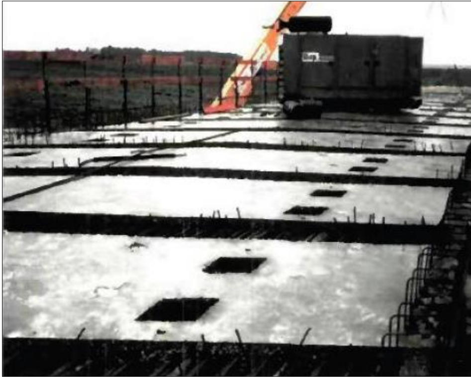
Figure VI.27 : Les plots préfabriqués de la dalle.
