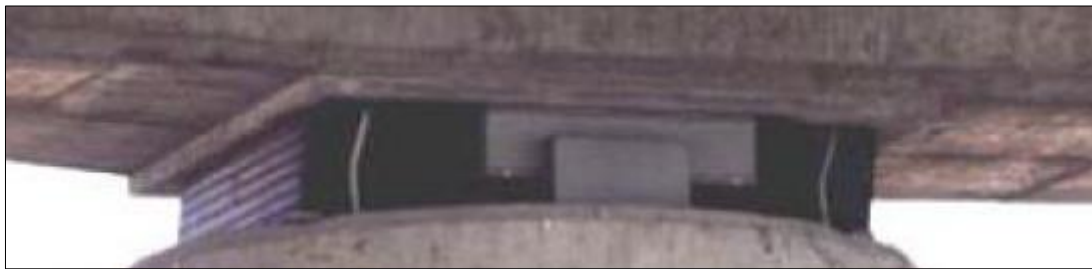
Figure VII.1 : Photo réelle d'un appareil d'appuis.
