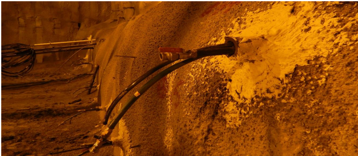
Figure 32: les tuyaux prêts pour l'injection.
