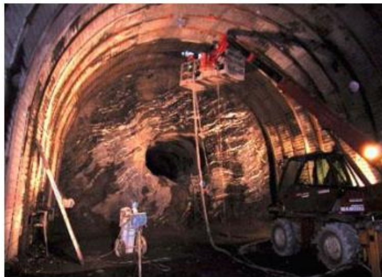
Figure III-6:Galerie de reconnaissance.
