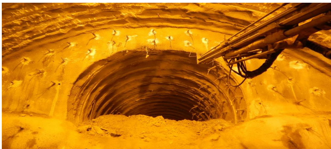
Figure III-9: Le front de taille du tunnel T4 (réalisation de la méthode FIT)
