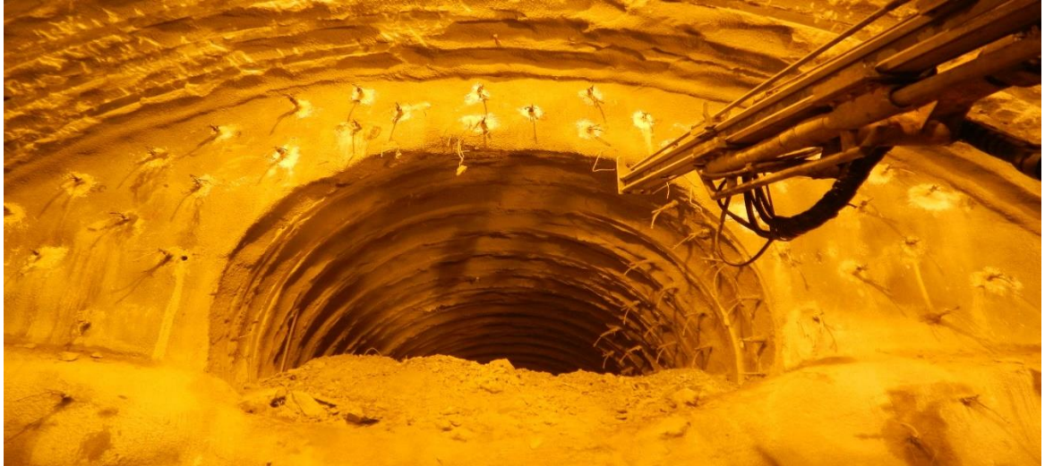
Figure 33: Galerie de reconnaissance dans le tunnel T4.
