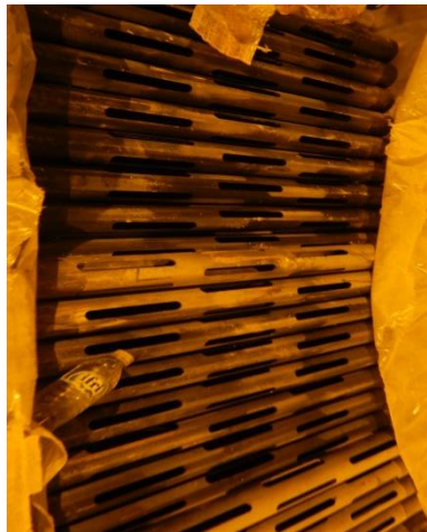
Figure III-10:Assemblage des tubes (GFRP).
