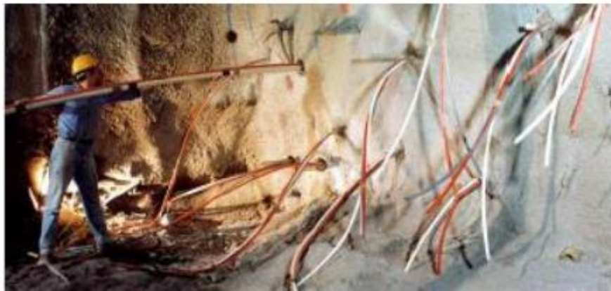
Figure II-14: Pose de boulons en fibre de verre au front de taille.
