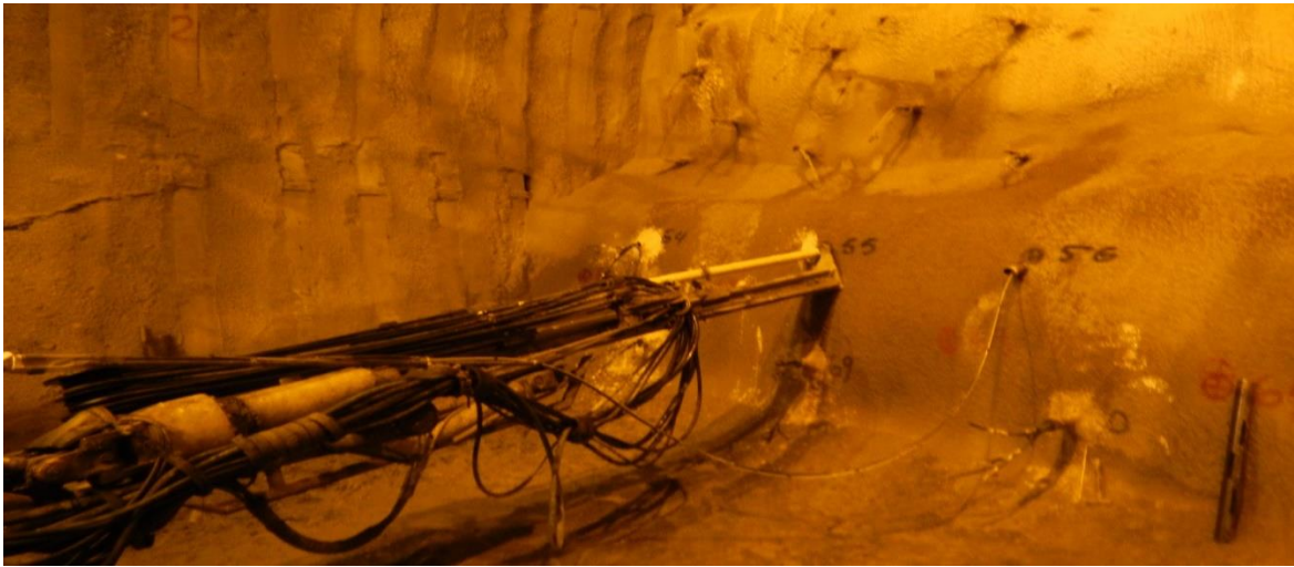
Figure 31: La mise en place du tube GFRP.
