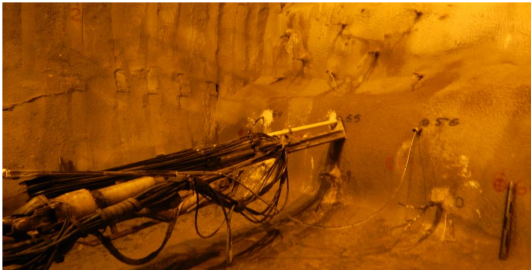
Figure III-8: Injection des tubes par jumbo.
