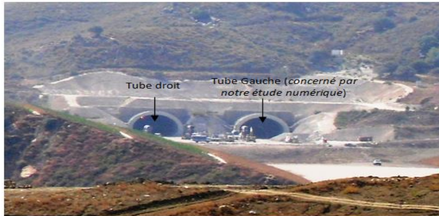
Figure III-2: Vue du portail nord du tunnel T4 (prise de la RN03).
