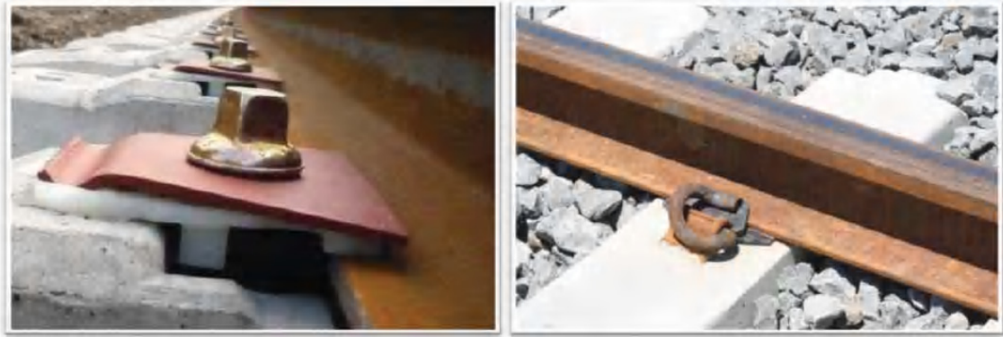
Figure III 9 Attache à lame de type Nabla [5] Figure III 10 Attache élastique de type e-clip [5]
