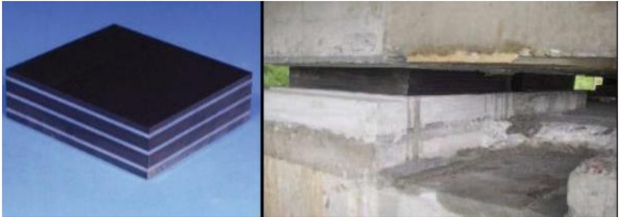
Annexe 6.1 : Appareil d'appui en élastomère frette
