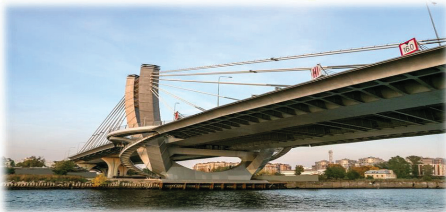
Figure I.5 pont en béton
