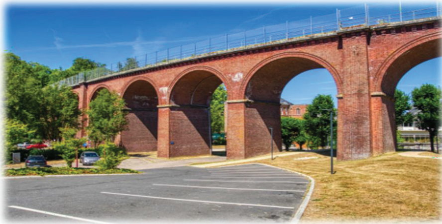
Figure I.4 pont en maçonnerie
