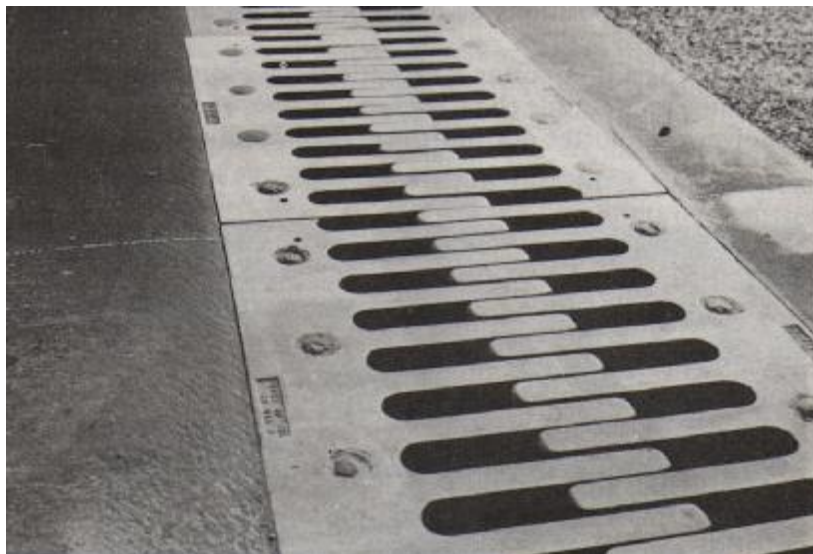
Fig.11.5. Joint de chaussée.
