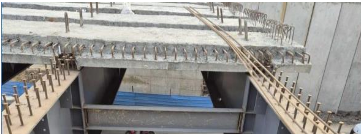
Figure V-6: Liaison de la dalle aux poutres métalliques.
