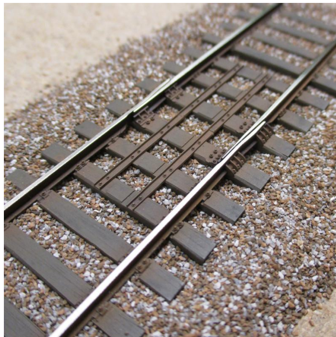
Figure VI-6: Appareil de dilatation ferroviaire ADF.
