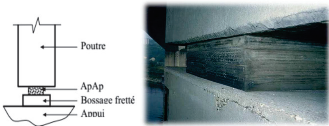
Figure I.23 ApAp sous une poutre
