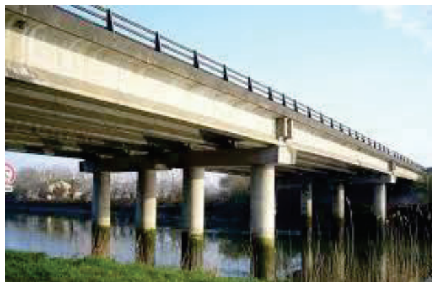
Figure I.8 Pont à poutres
