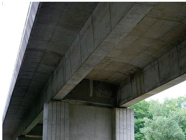
Figure I.5 Pont en Béton Précontraint
