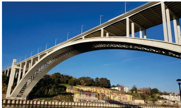
Figure I.10 Pont en arc (à tablier supérieur)
