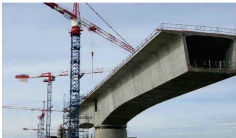
Figure I.11 Pont caisson (voussoir)
