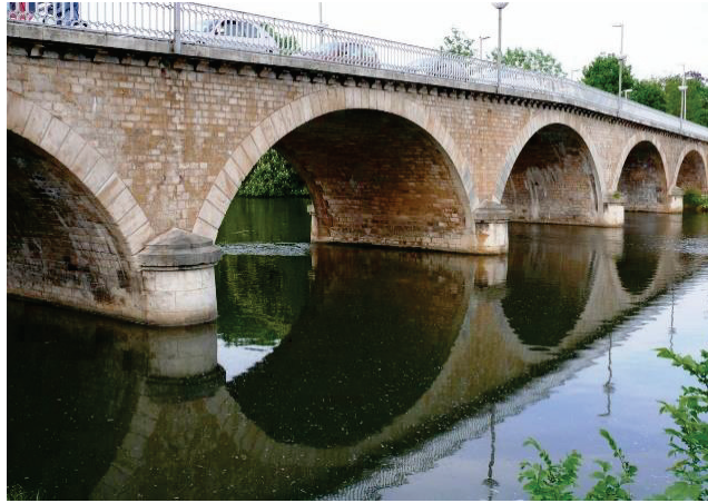
Figure I.3 Pont en maçonnerie
