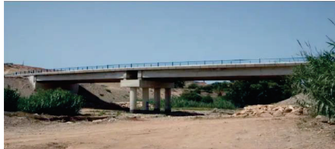
Figure I.4 Pont a travées indépendantes en Béton Armé
