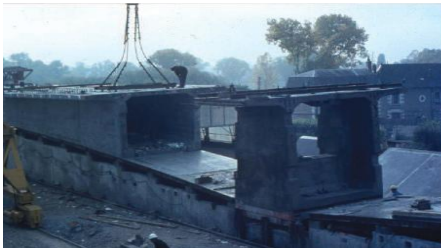
Figure I.6. voussoir préfabriqué sur une doucine
