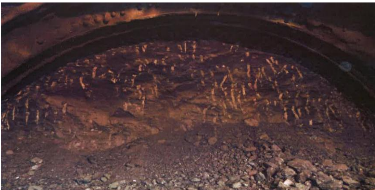
Figure III. 2 : le front au PK 36+217.
