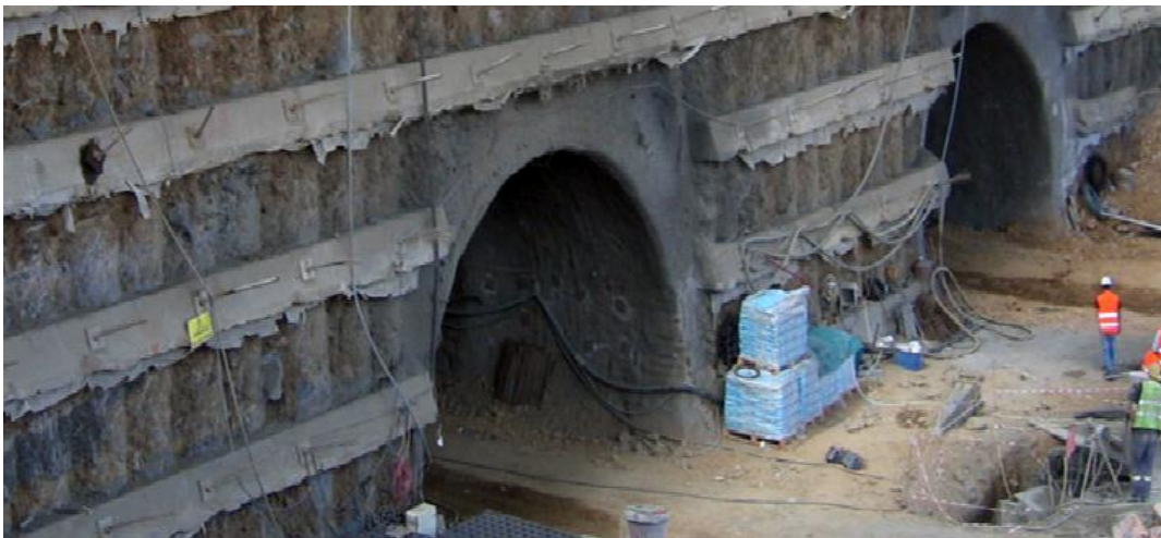
Figure IV. 1: Mur en pieux avec tirants d'ancrages.
