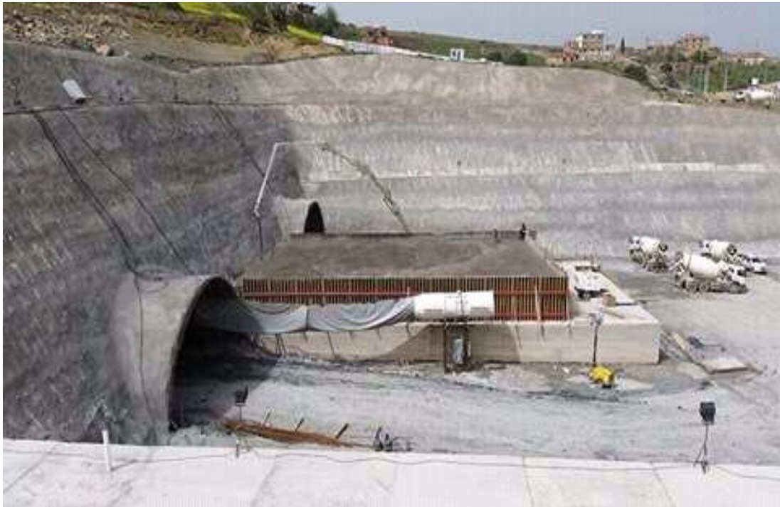
Figure IV. 3 : butée en béton armé en cours de réalisation.
