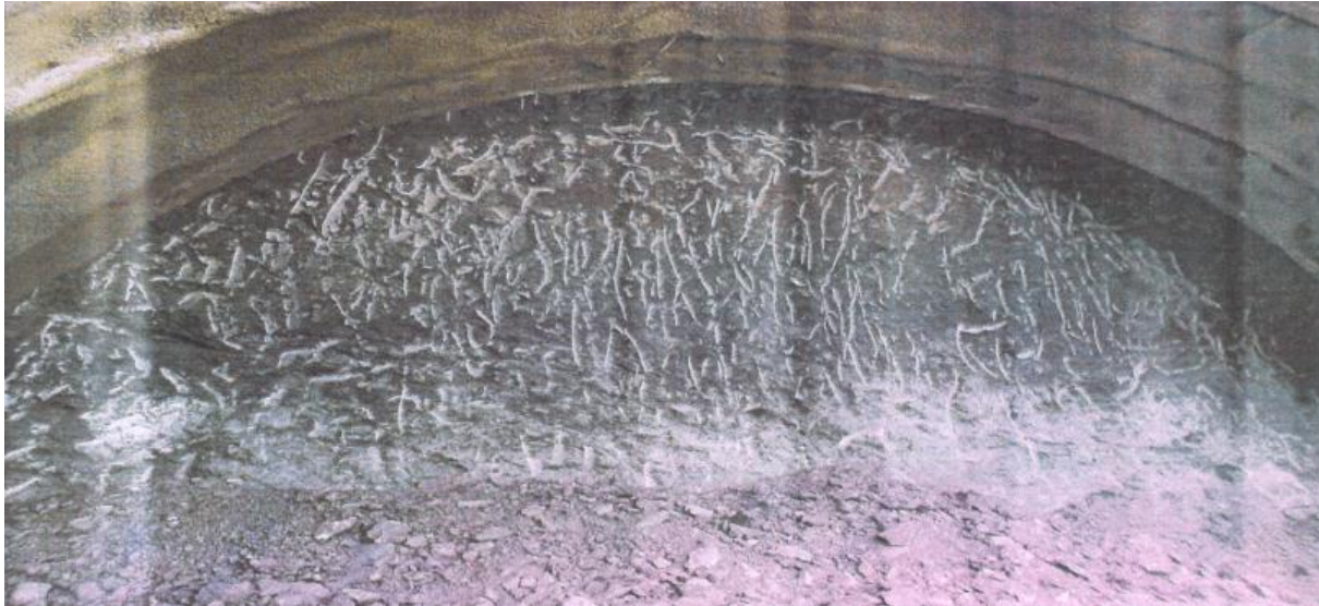
Figure III. 1 : le front au PK 36+202.
