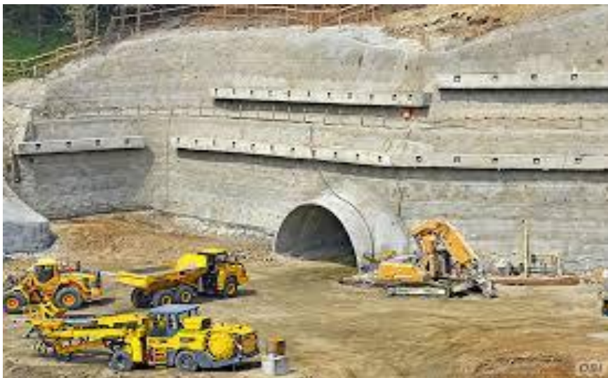
Figure IV. 4 : Stabilisation des talus par des poutres ancrées.
