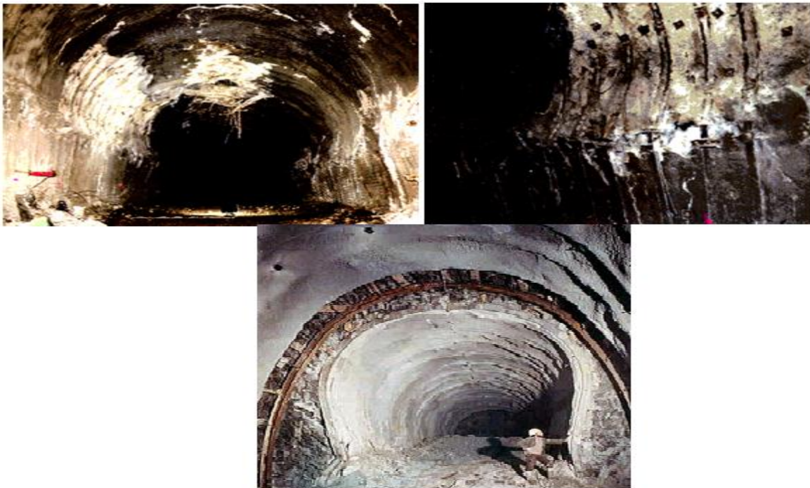
Figure I. 3 : convergence des parois d'un tunnel.
