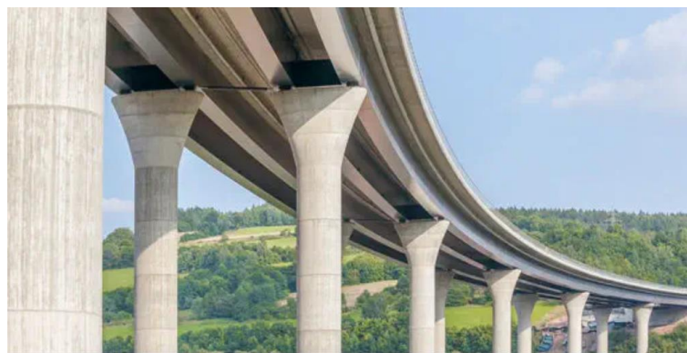
Figure I. 5 Pont en béton précontraint en Allemagne
