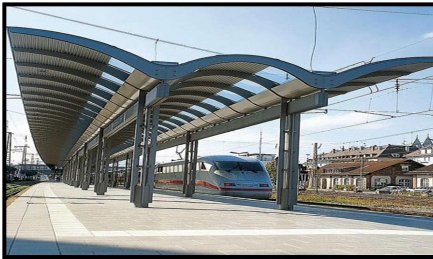
Figure VIII.5. Abris de quai.
