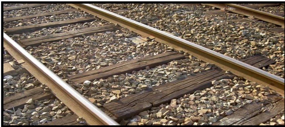
Figure III.3. Traverse en bois.
