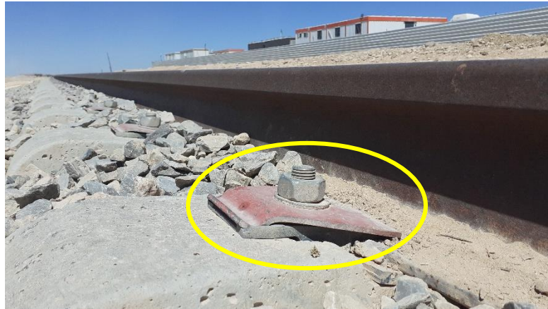
Figure VI - 5 Système d'attache souple « NABLA »
