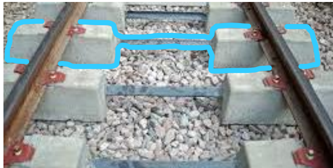
Figure VI - 6 Traverses bibloc en béton armé
