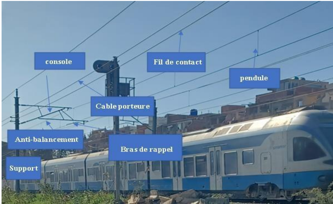
Figure XI - 2 Élément de caténaire
