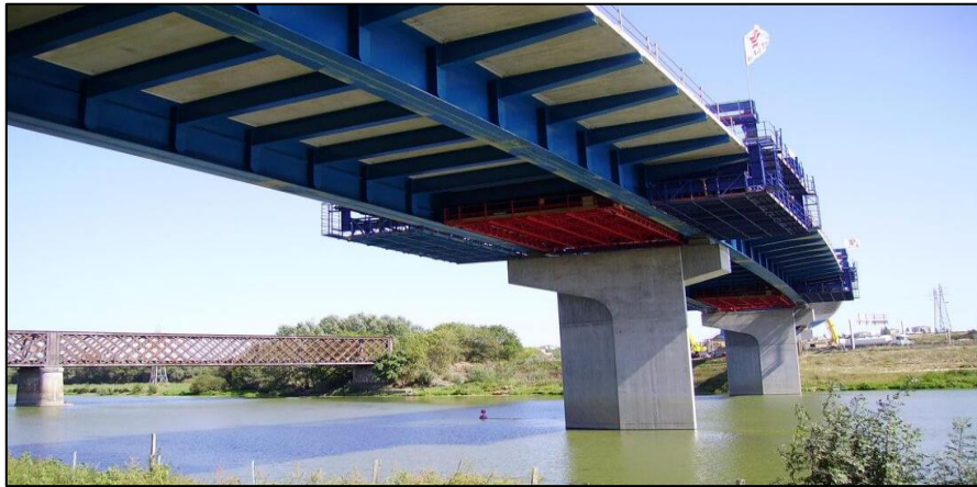
Figure II.2 : Morphologie générale d'un pont mixte
