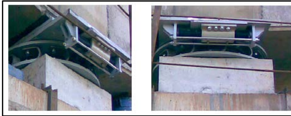
FigXV.8 : détail des appareils d'appuis sur les piles.
