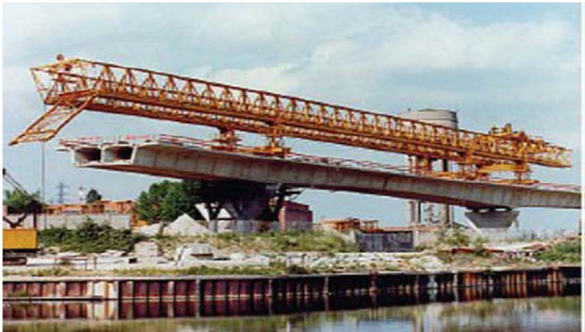
FigV12 : poutre de lancement.
