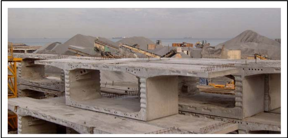
FigV9 : zone de préfabrication des voussoirs.
