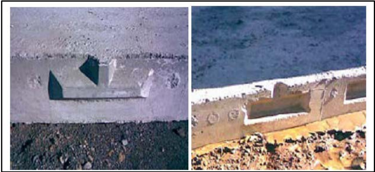
FigV11 : détails des clés sur hourdis.
