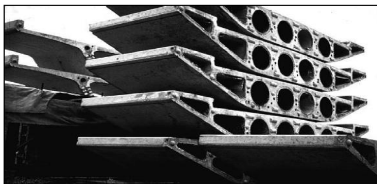
Fig.I.6 : Stockage des voussoirs préfabriqués.
