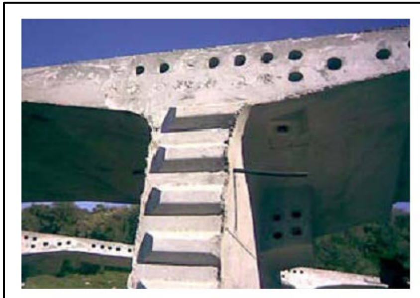
Fig V10 : détails des clés sur âme.
