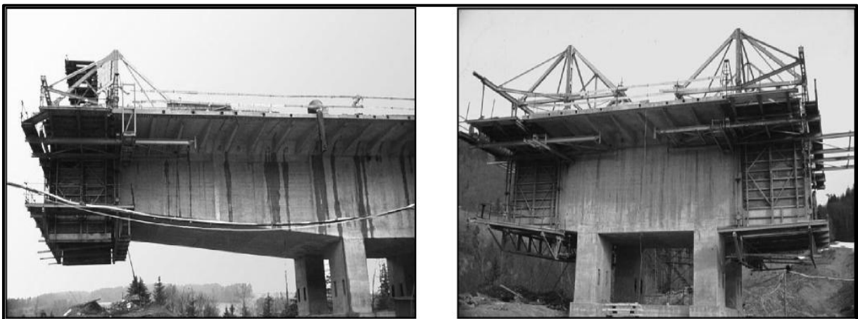
Fig. I.6. Voussoirs coulés sur place.
