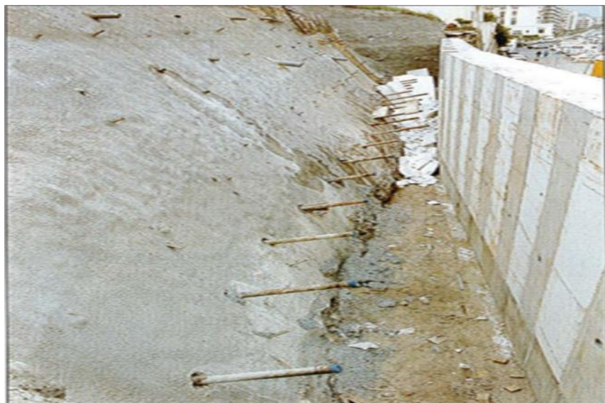
Figure I-29 : confortement de glissement de Saint-Jean-de-Luz (Pyrénées- Atlantiques) par tirants d'ancrage. [IIIV]
