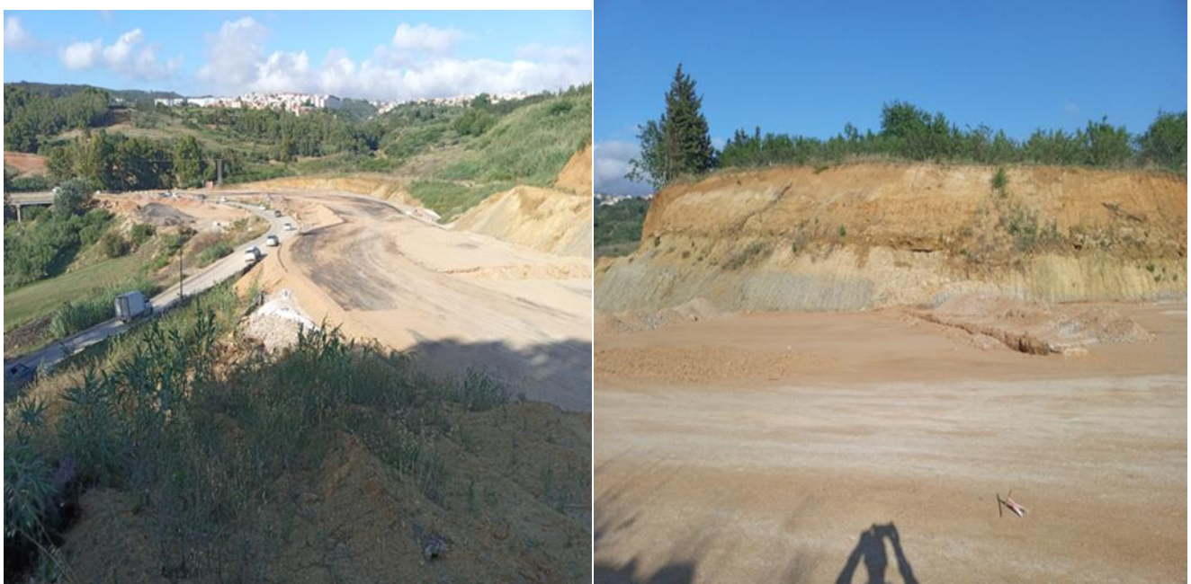
Figure II-9 : CW111 vue du contournement en travaux JUIN 2023.
