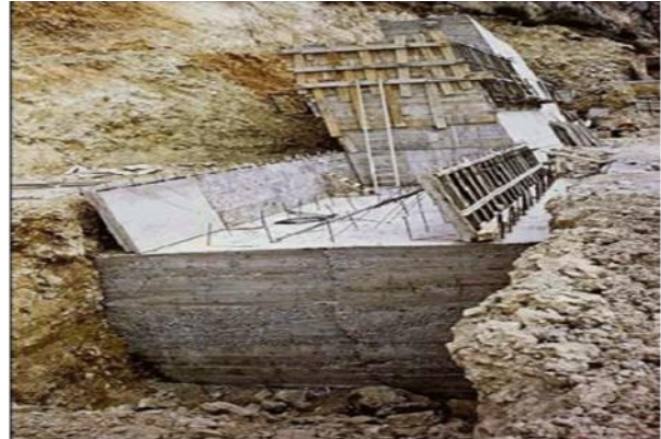
Figure I-27 : ouvrage rigide (mur poids). [XIII]
