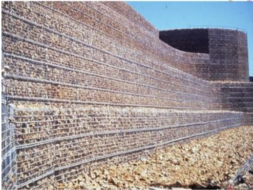
Figure I-28 : ouvrage souple (mur en gabions). [XIII]
