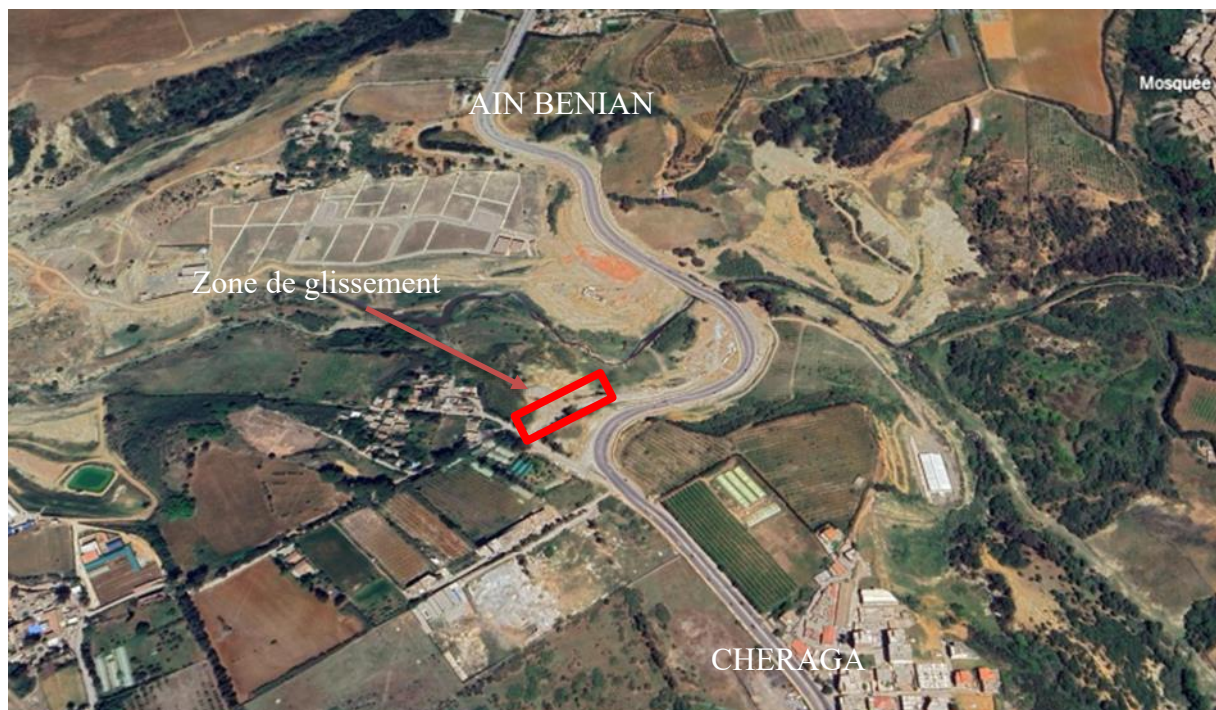
Figure II-1 : Localisation de la zone de glissement sur google earth.
