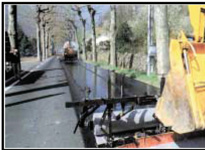
Figure I.4-2 Mise en place du géotextile sur la couche d'accrochage
