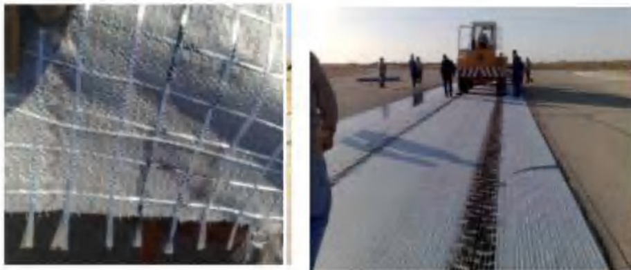
Figure V.1 Echantillon et mise en place de géotextile
