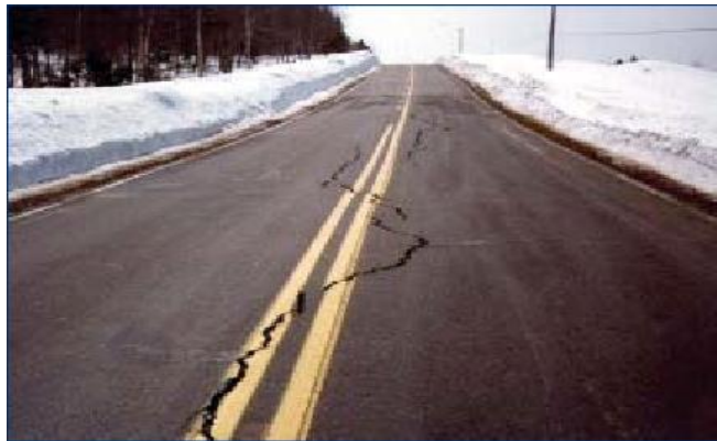
Figure 11:Fissures longitudinales
