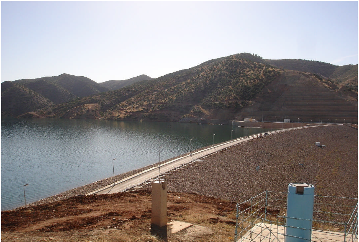
Barrage réservoir d'Oued Athmania
