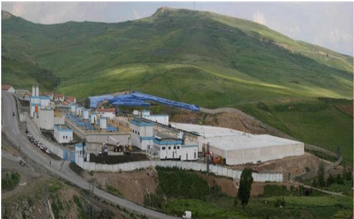
Complexe des eaux
