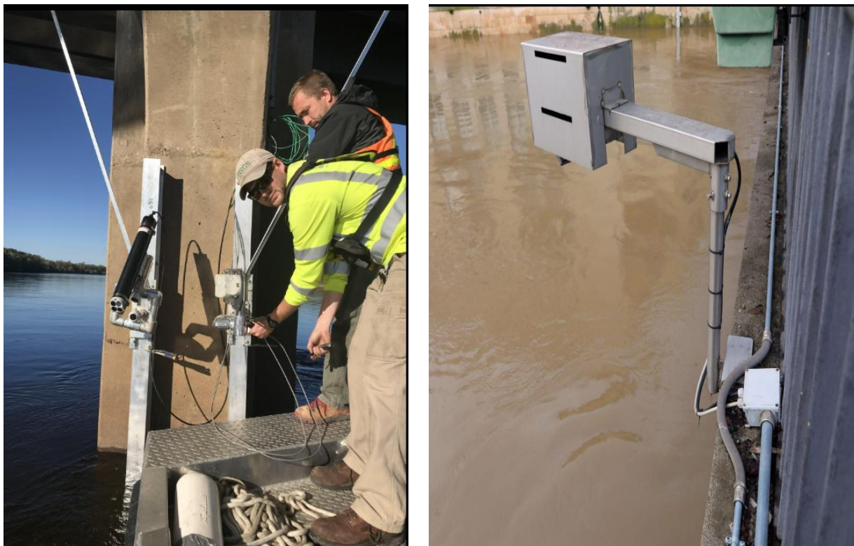
Figure I.17 : Surveillance et Maintenance des Ponts.
