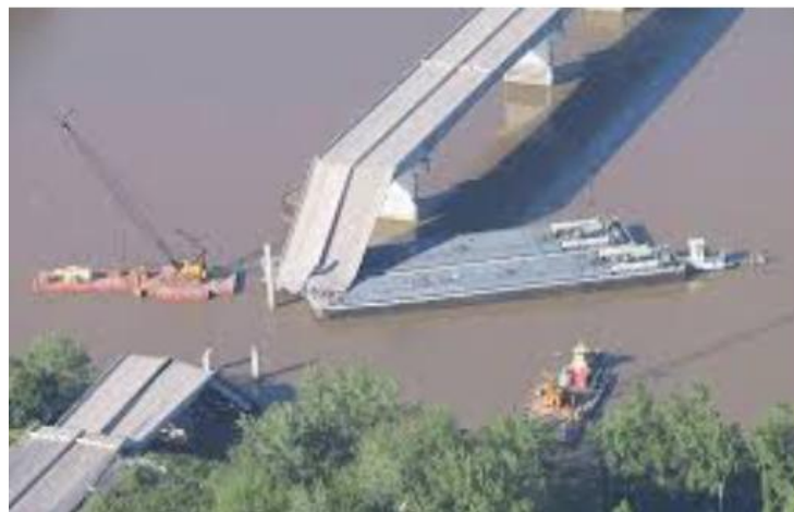
Figure I.12 : Pont de la rivière Hatchie-Tennessee, Etats-Unis (1989).
