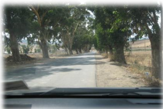
La chaussée existante
