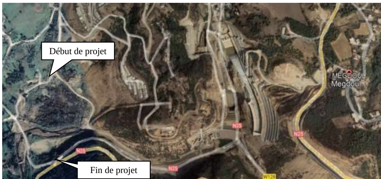
Figure I.1: Implantation du projet sur Google maps.
