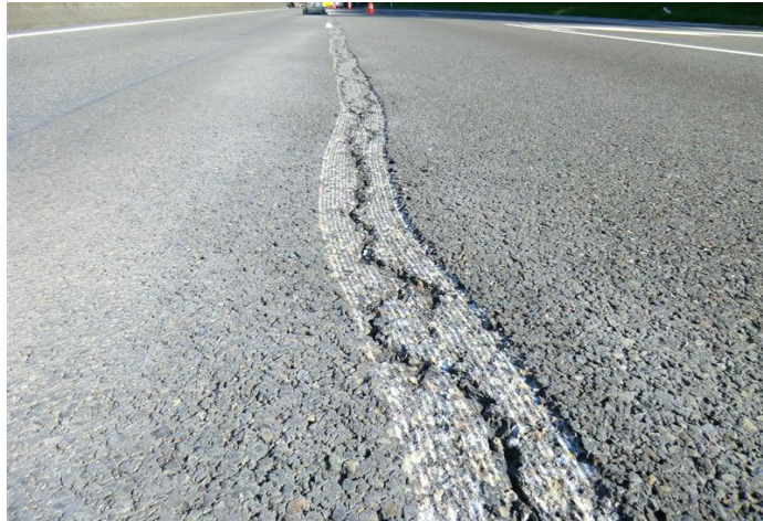
Figure I.2:Fissure longitudinale.
