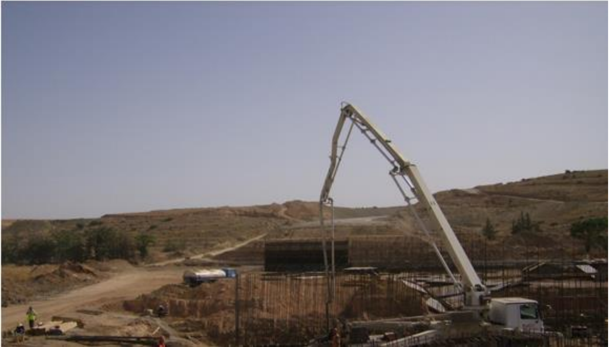
Figure 8.9 : Fin du projet de la pénétrante de Tlemcen – Hammam Boughrara en cours de réalisation
