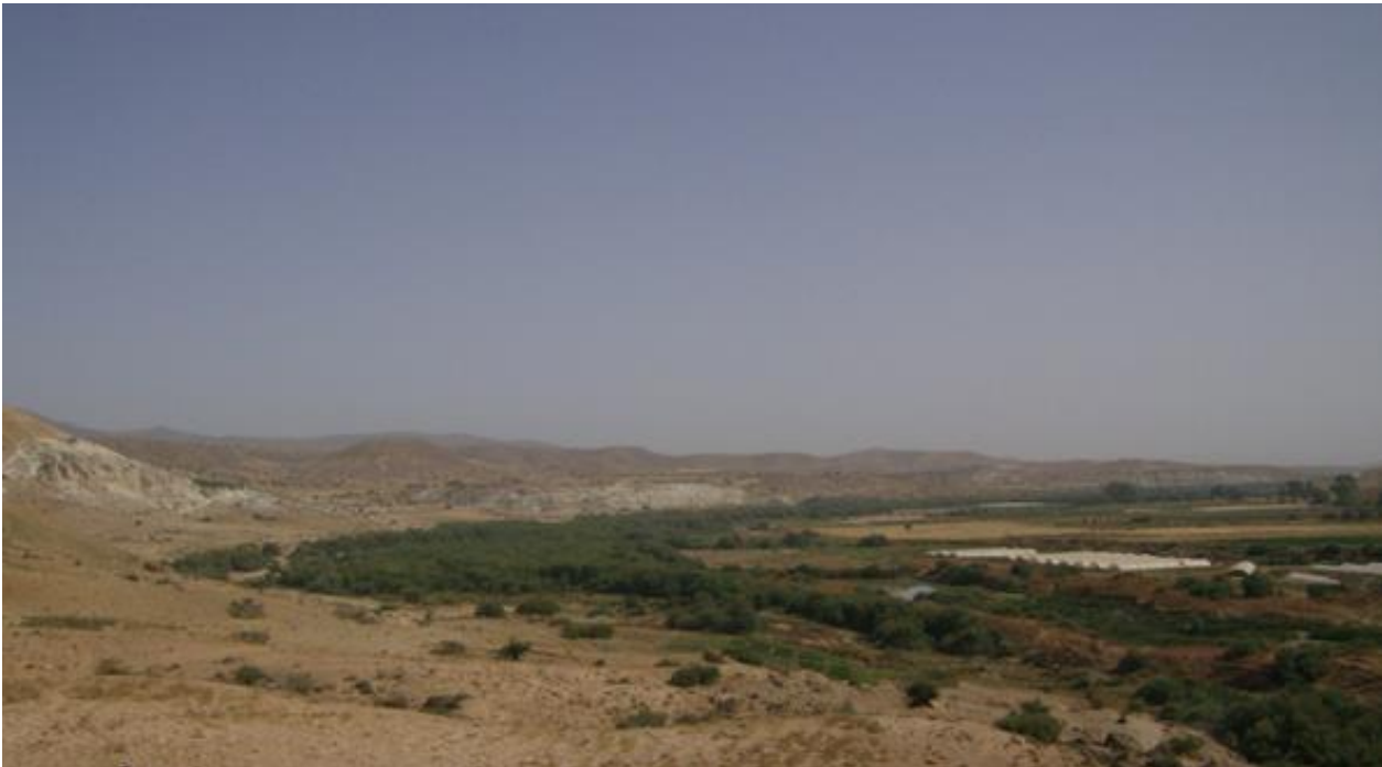
Figure 8.10 : Traverse d'oued et raccordement à l'échangeur Hammam boughrara
