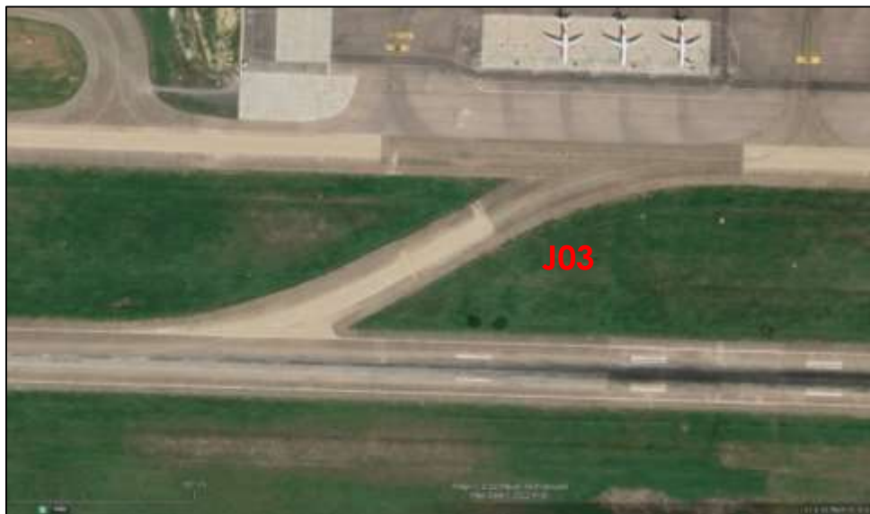
Figure VIII. 4 Aperçu sur la voie de sortie rapide J03
