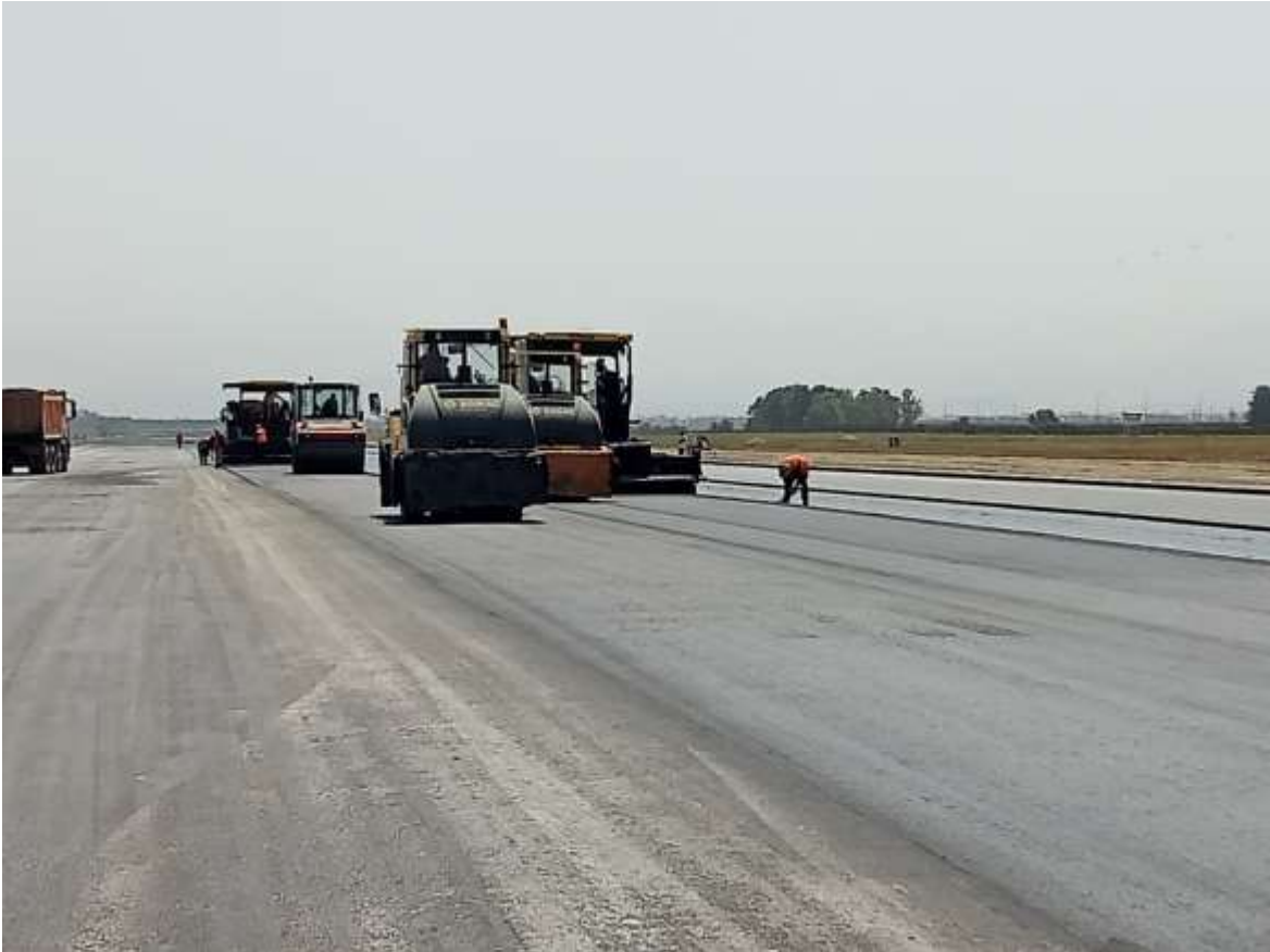
Figure : Réalisation du EME
