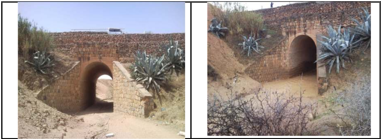
X-1 :Photos qui représenté l'état des ouvrage d'assainissements.
