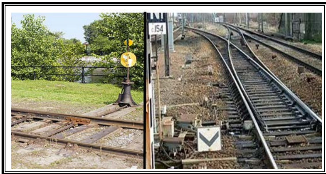
Figure II.14 : Aiguillage manœuvrée à pied d'œuvre et à distance.
