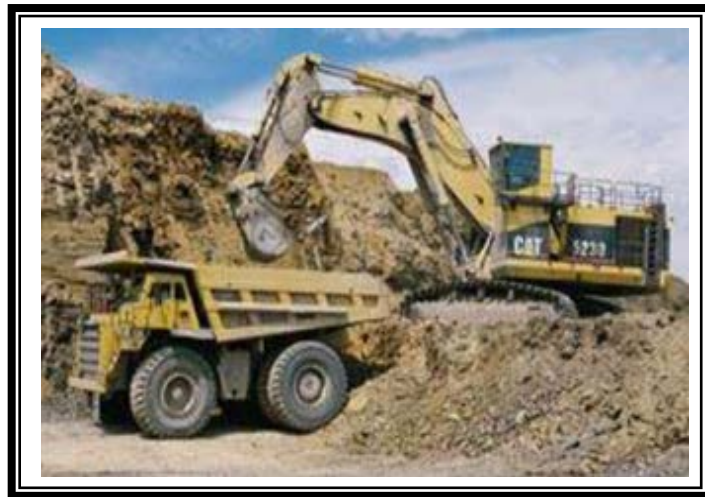
Figure IX.1: travaux de terrassement.
