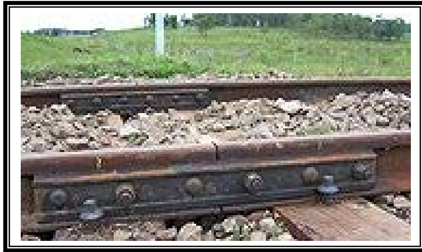
Figure II.5 : joint de rail éclissé.
