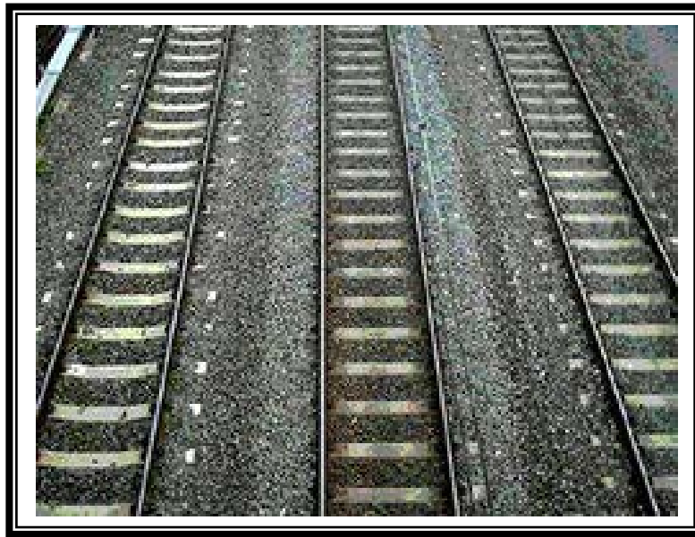
Figure II.1 : voie ferrée et ballast.
