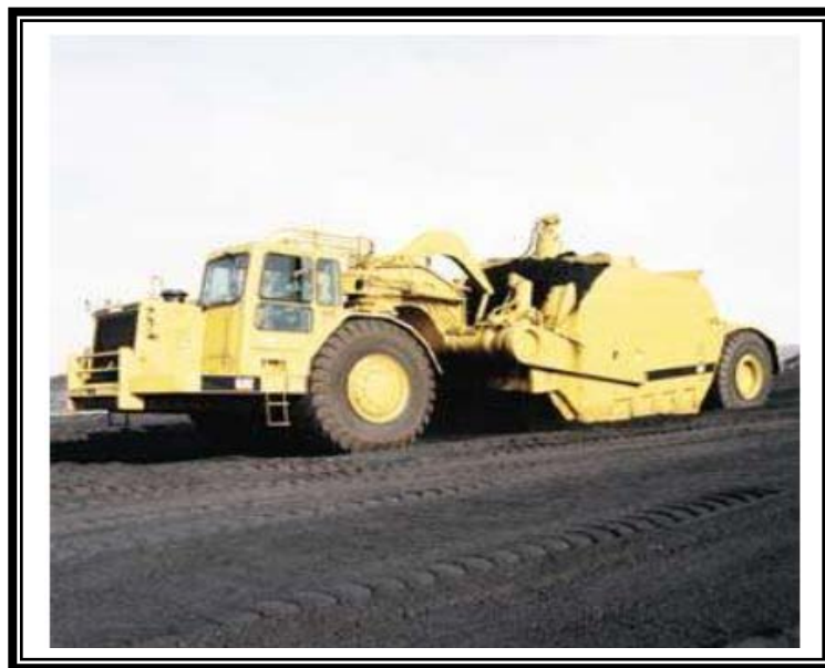
Figure IX.2 : exécution d'ouvrage en terre.
