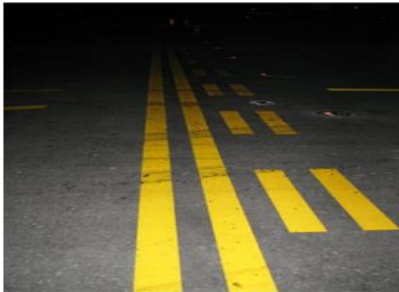
Marquage avec des billes de verre catégorie I visible jusqu'à 25 m.
